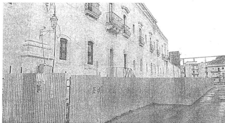
I LAVORI DI RISTRUTTURAZIONE A PALAZZO DEI MERCEDARI
